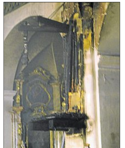
Die verkohlten Stümpfe von Bodenplatte und Dach sind alles, was von der Kanzel übrig geblieben ist.
